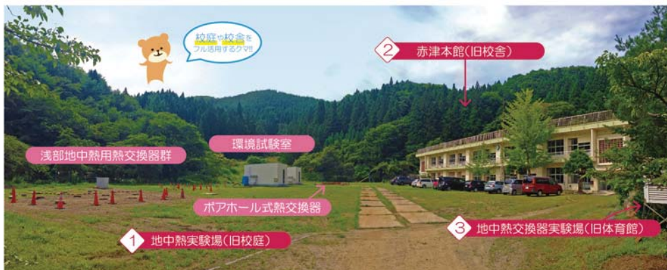
図2 郡山市湖南町の旧赤津小学校(廃校)を利用した郡山市・日本大学工学部再生可能エネルギー共同実験施設
