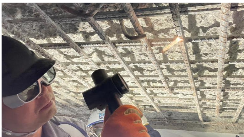
写真-1 レーザーの照射状況
