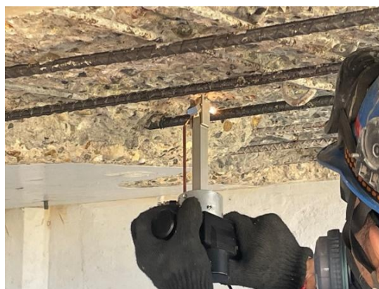
鉄筋背面の施工状況
