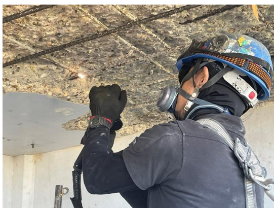
鉄筋正面の施工状況
