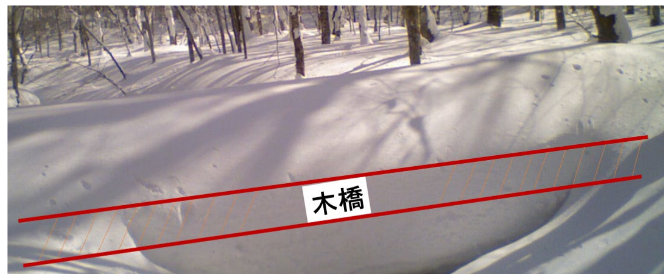
従来の木橋の積雪状況(赤線は橋の位置)
